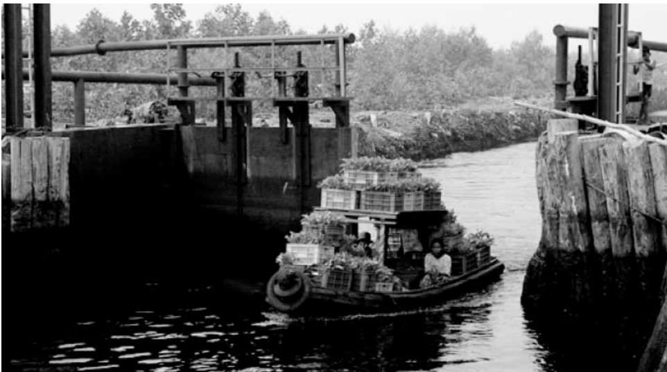
Kapal pengantar bibit menyeberangi pintu air (yang mempertahankan tinggi kawasan air dan mencegah pangaliran air berlebihan).
