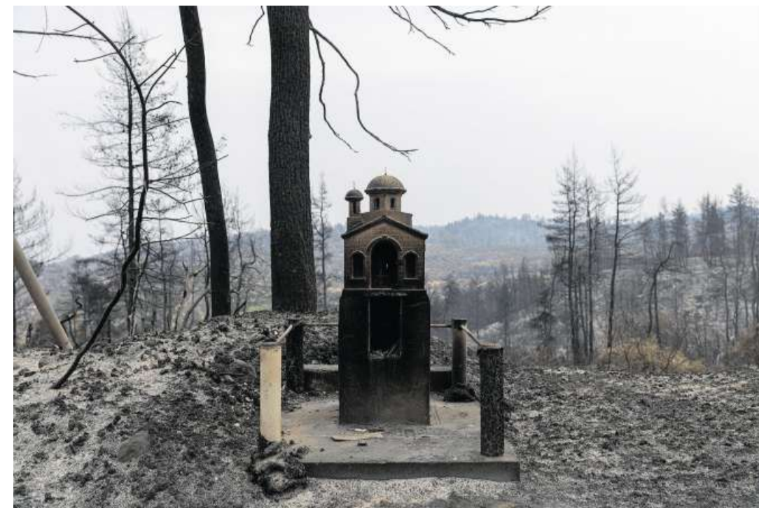
Eine ausgebrannte Kapelle am Strassenrand bei Pefki.
