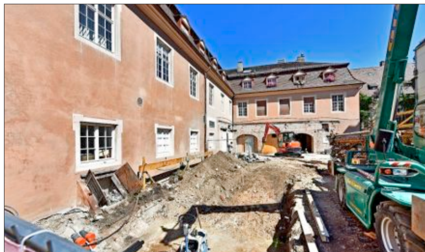
Baggerarbeiten im Hof des „Erzherzogs“
