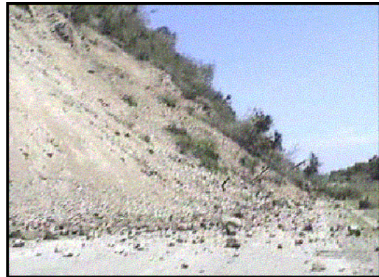
Figura 3. Deslizamiento producido por lluvias intensas en la carretera Granma.
