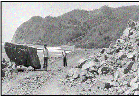
Figura 2. Deslizamiento producido en la carretera Granma por el sismo del 19 de febrero de 1976 de M = 5.7 Richter.
