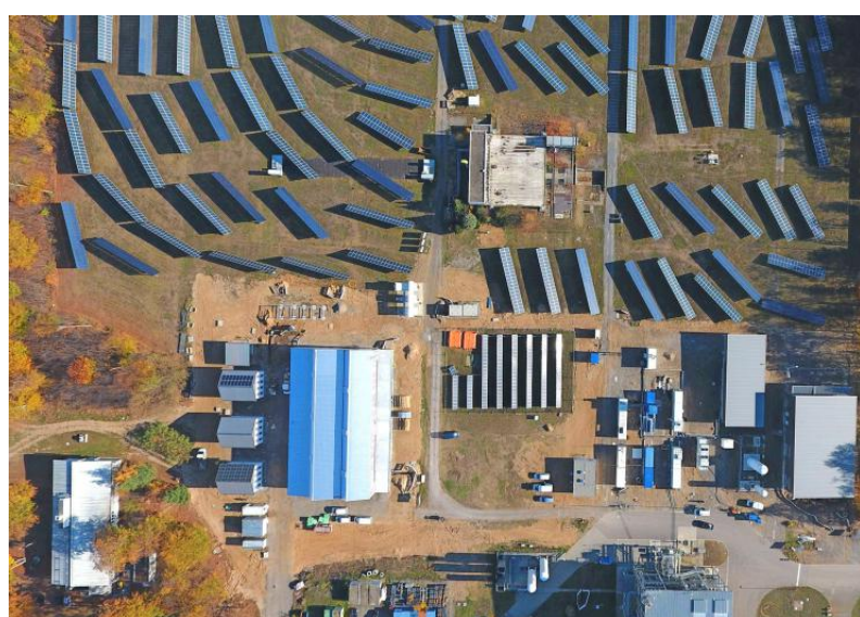
Luftaufnahme der unterschiedlichen Energiesystemkomponenten auf dem Campus Nord des Karlsruher Instituts für Technologie. FOTO: SEBASTIAN MANG, KIT
