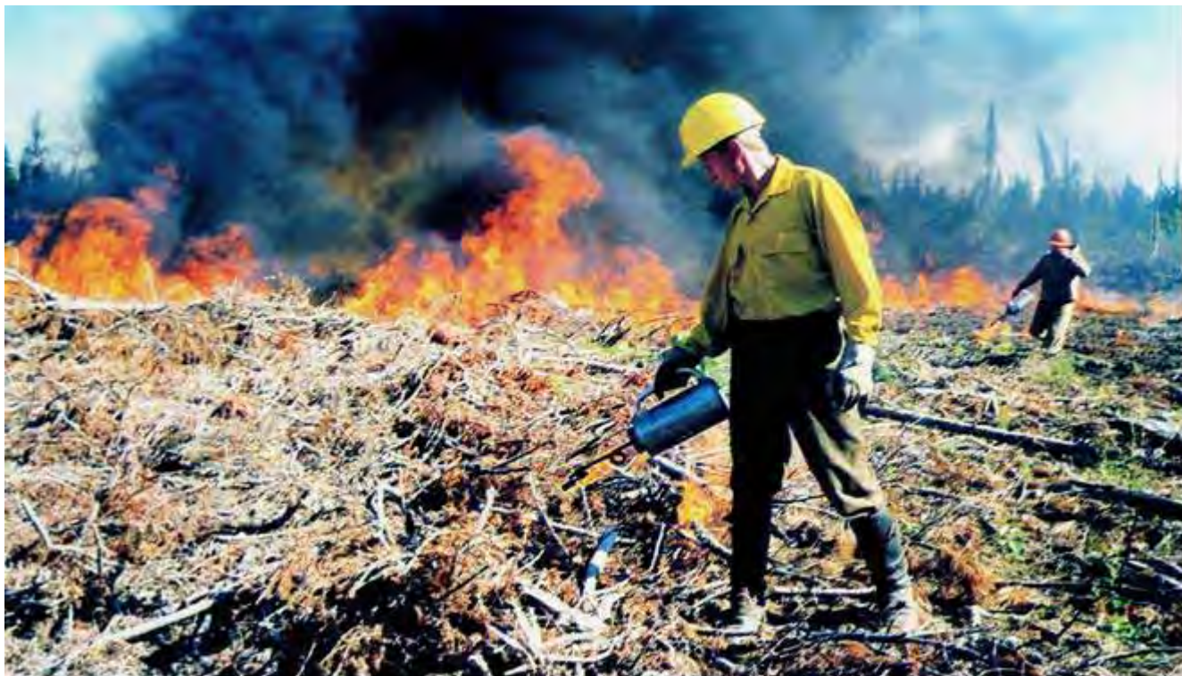
ФОТО 7. Контролируемое выжигание. Зажигание порубочных остатков на вырубке линейным способом.
