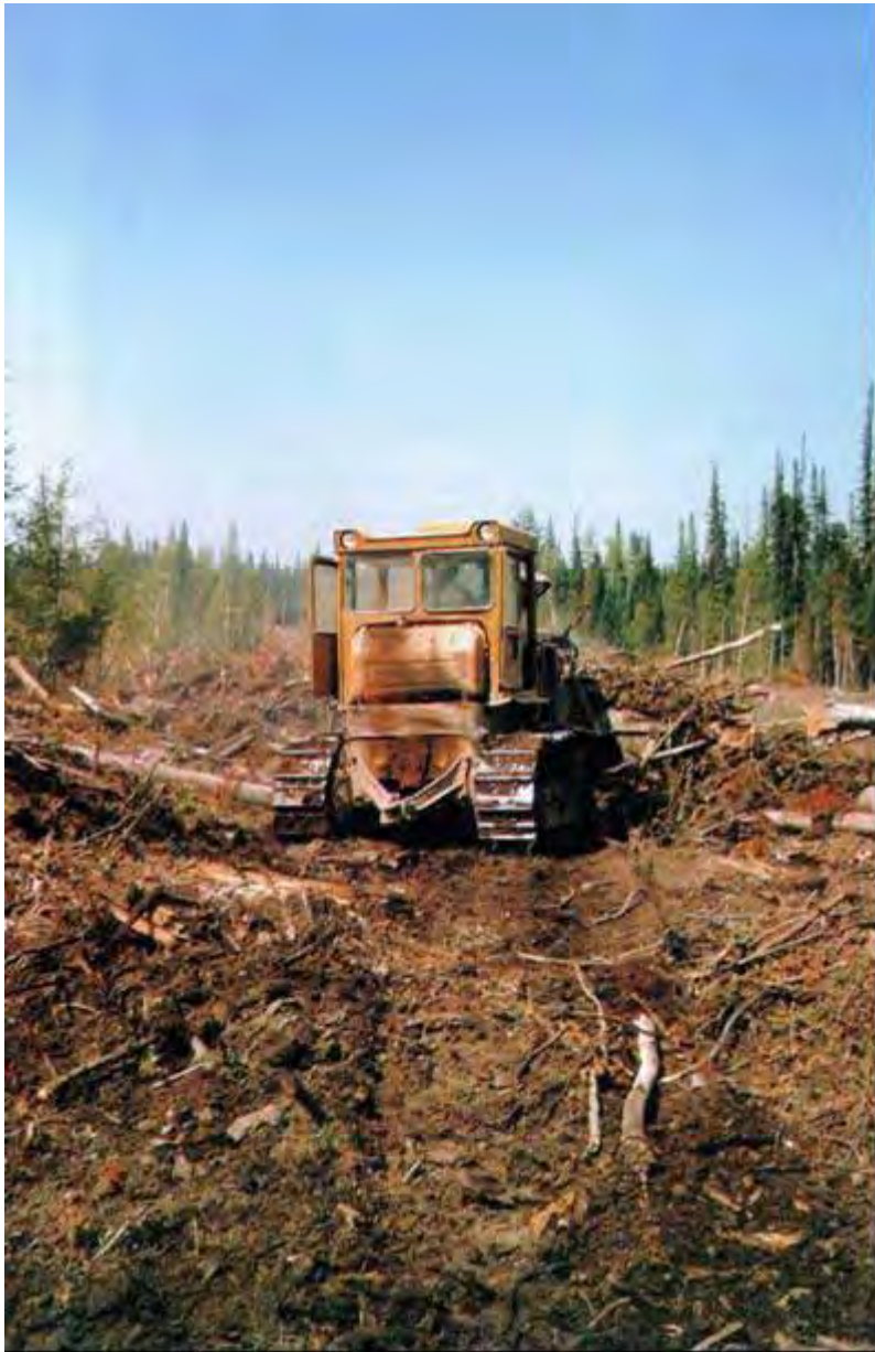
ФОТО 13. Для прокладки минерализованных полос на захламленной вырубке наиболее эффективно использование бульдозера с поворотным ножом.
